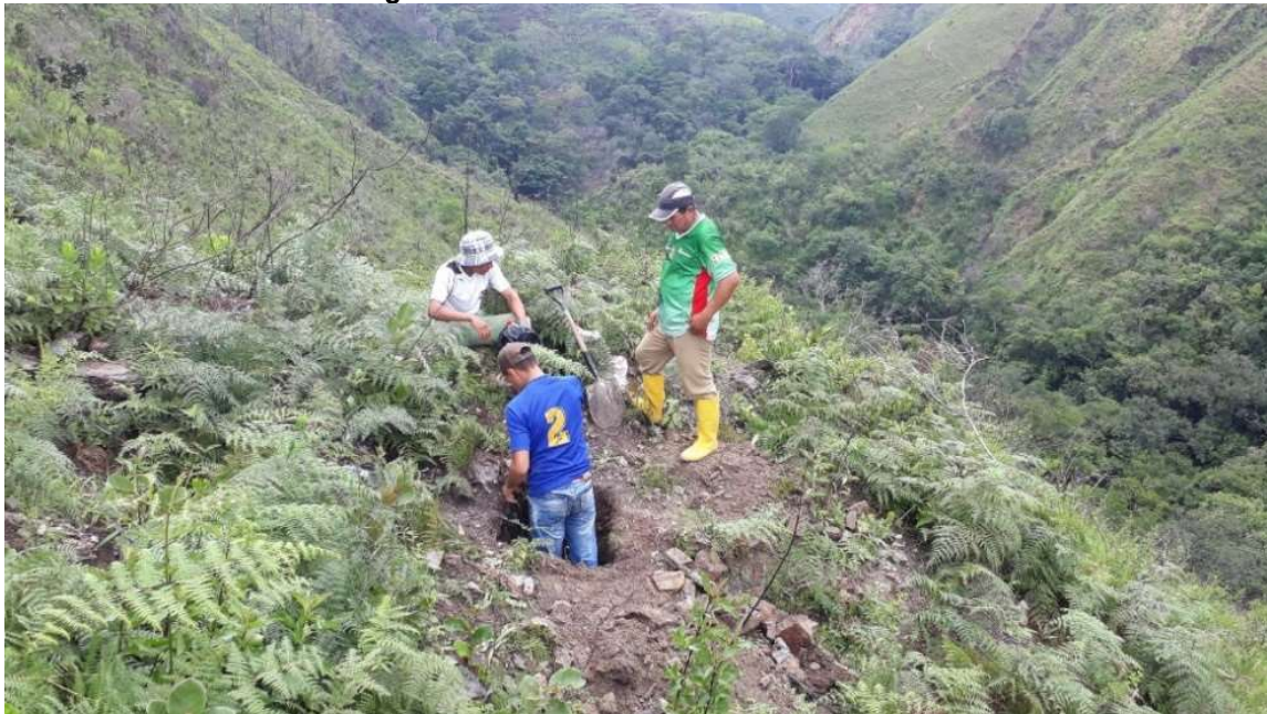
Fotografía 5.2 Calicatas en la línea de conducción
