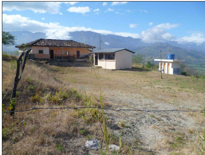
Fotografía 2.3 Vista General De La Escuela "Ciudad De Madrid" Del Barrio San Roque
