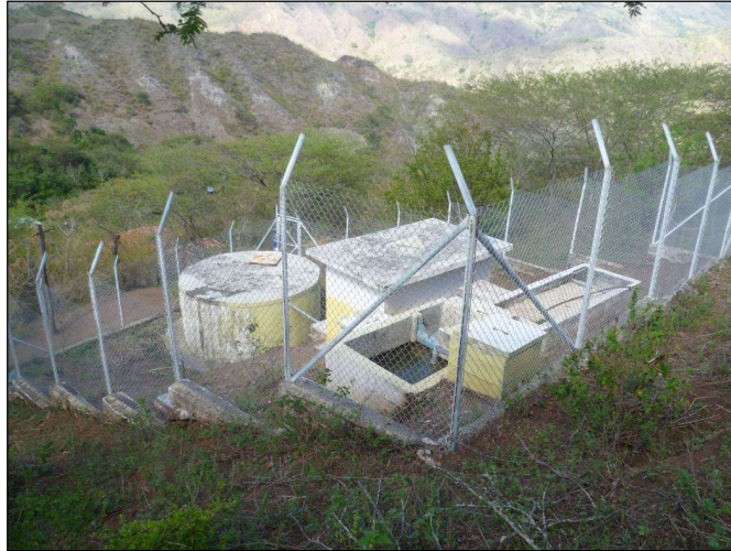
Fotografía 2.4 Vista de la Planta de AA. PP. del Barrio Tungani
