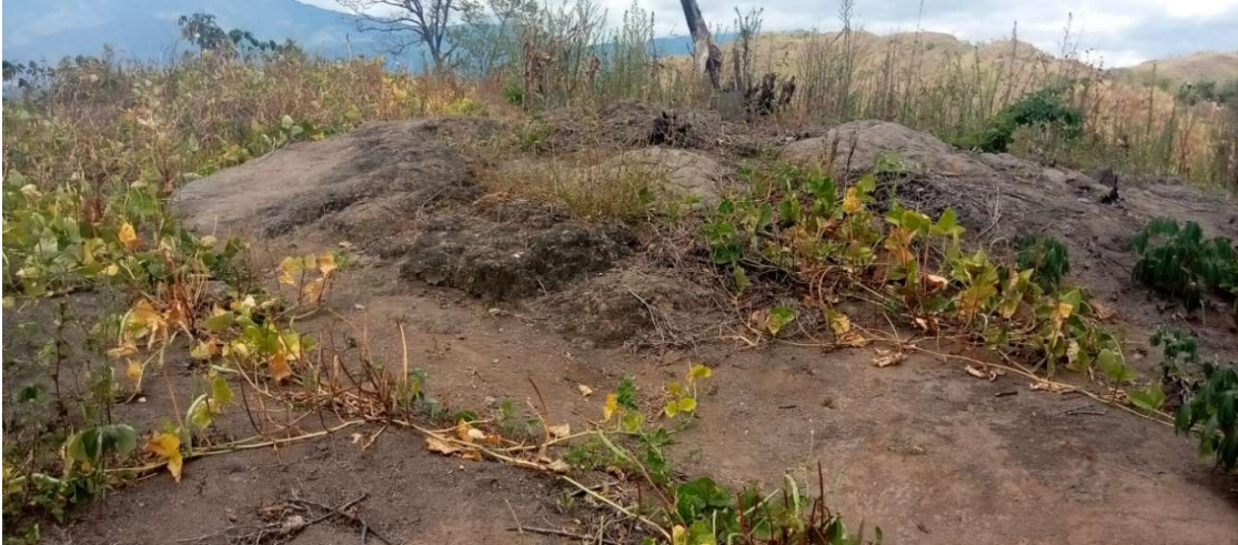
Fotografía 5.9 Se Observa un Estrato Rocoso en la Red de Distribución
