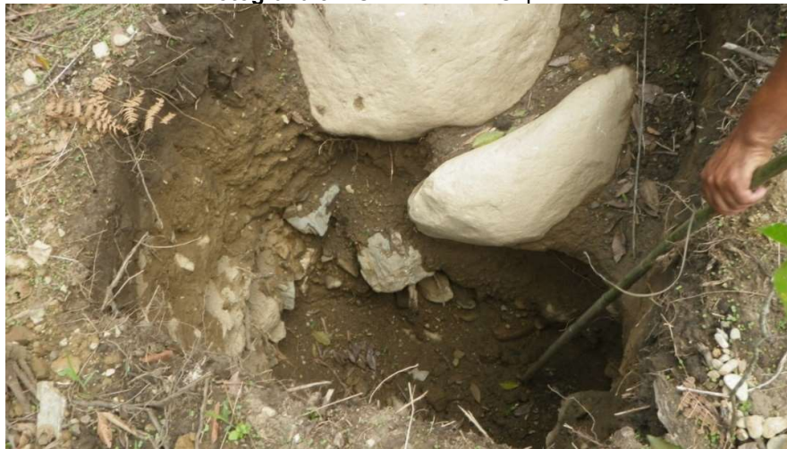
Fotografía 5.4 Calicata en la Captación
